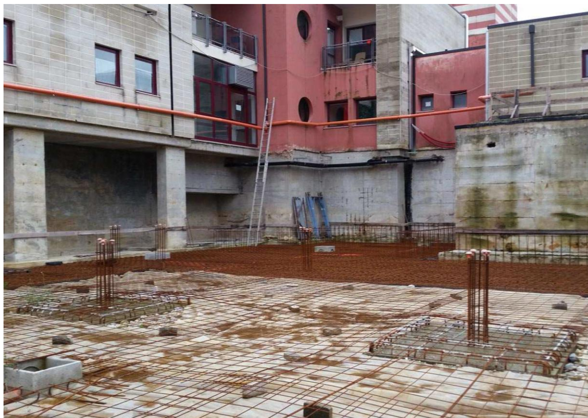
Plinti dei pilastri e bypass scarichi e pluviali appesi alle murature esistenti
