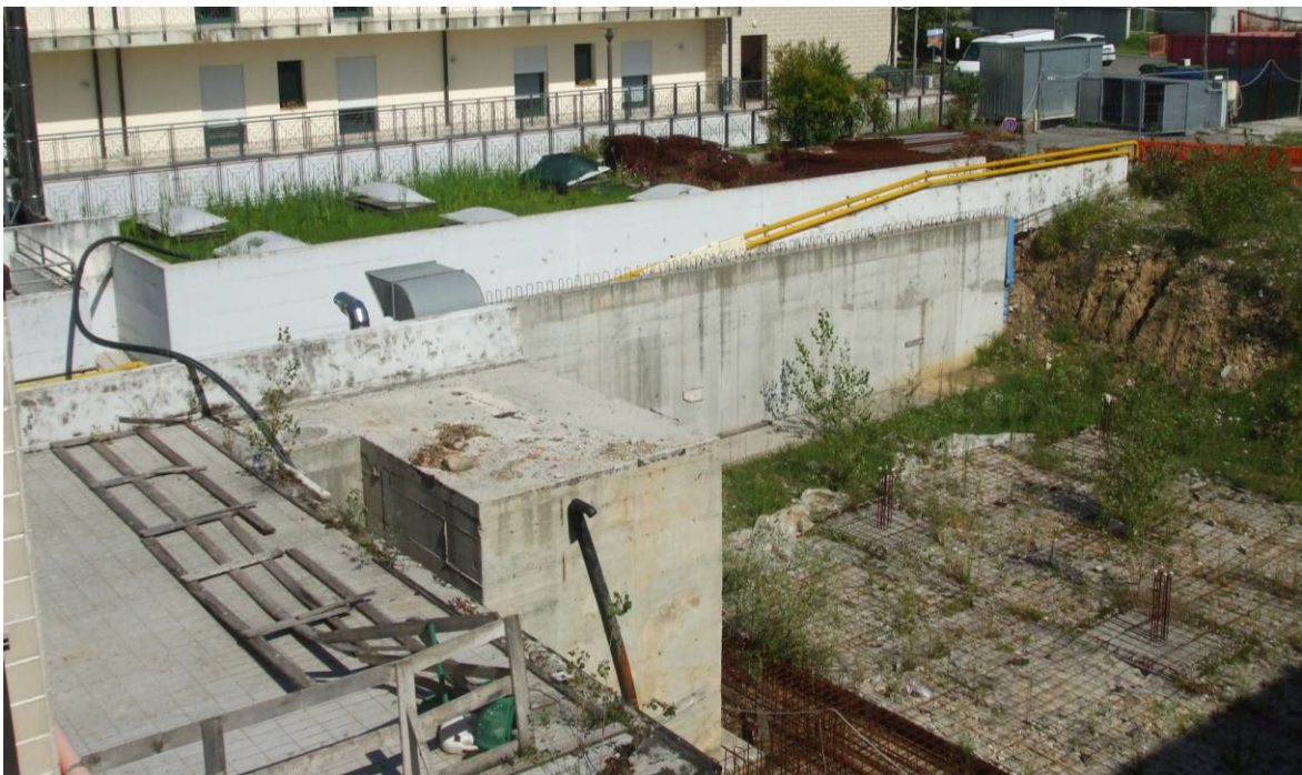
Scavo e setto realizzato
