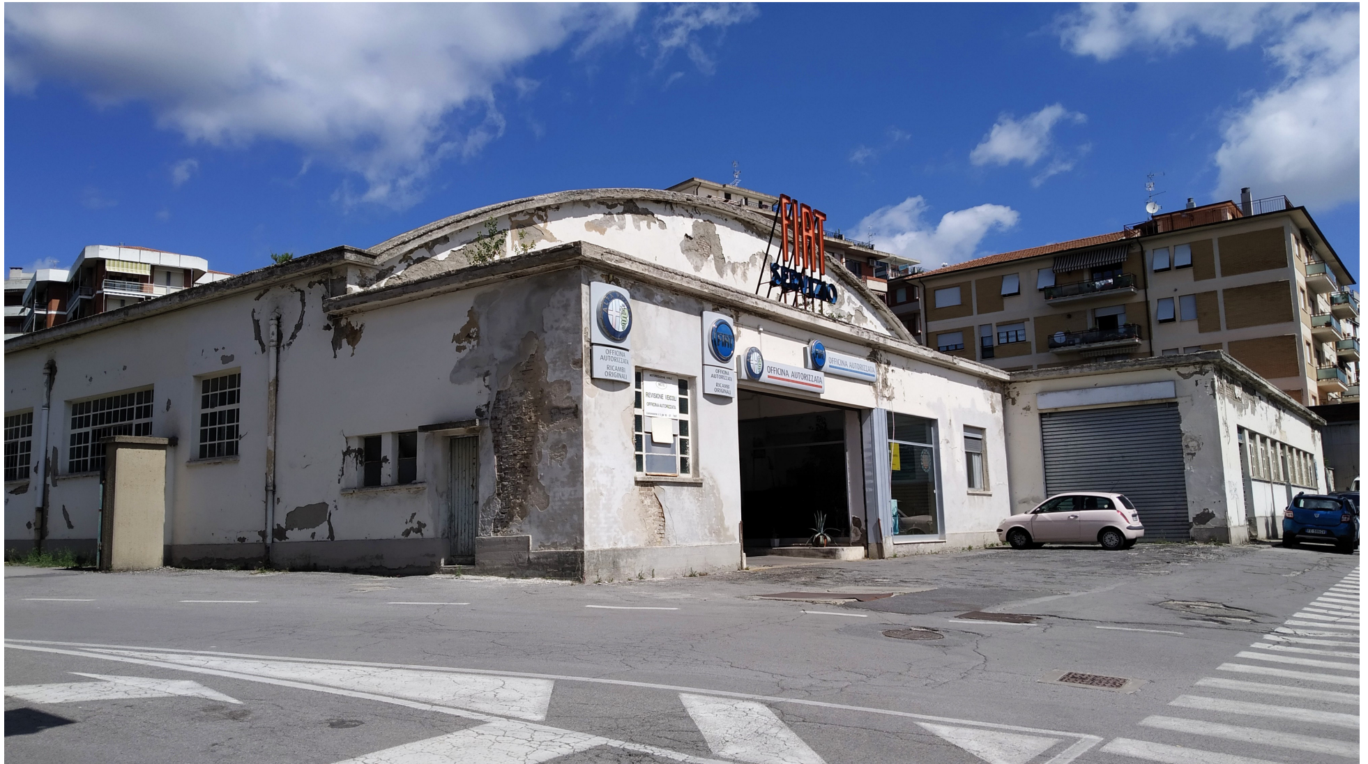
Foto fronte principale officina Fiat
