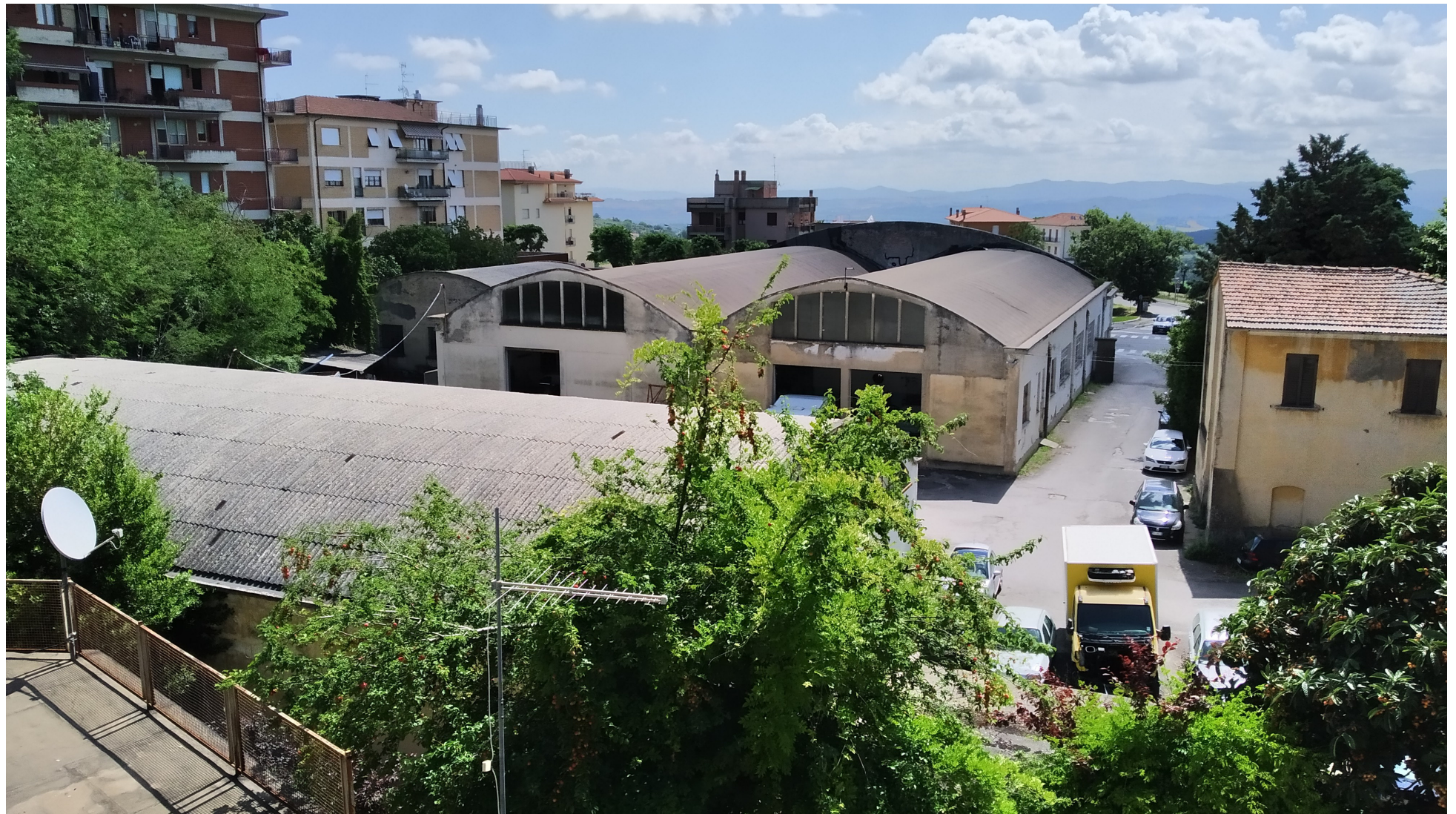
Vista area Fiat da lato posteriore
